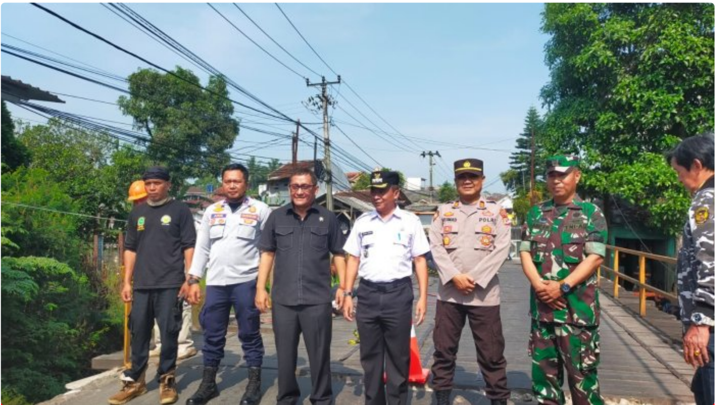
Laksanakan Pengamanan Penutupan Jembatan yang Rusak Kapolsek Cidahu Bersama Forkopimcam Cidahu
