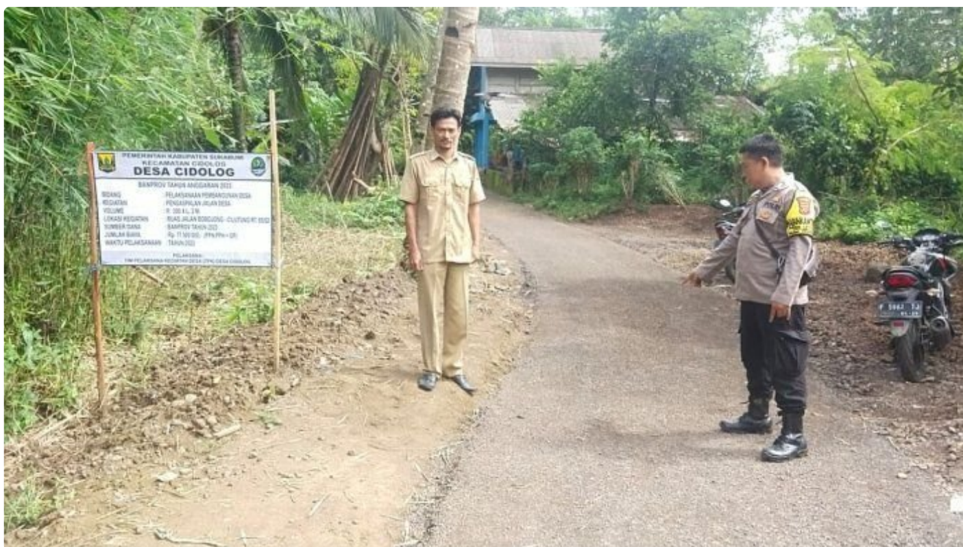
Bhabinkamtibmas Desa Cidolog Awasi Pembangunan Desa
